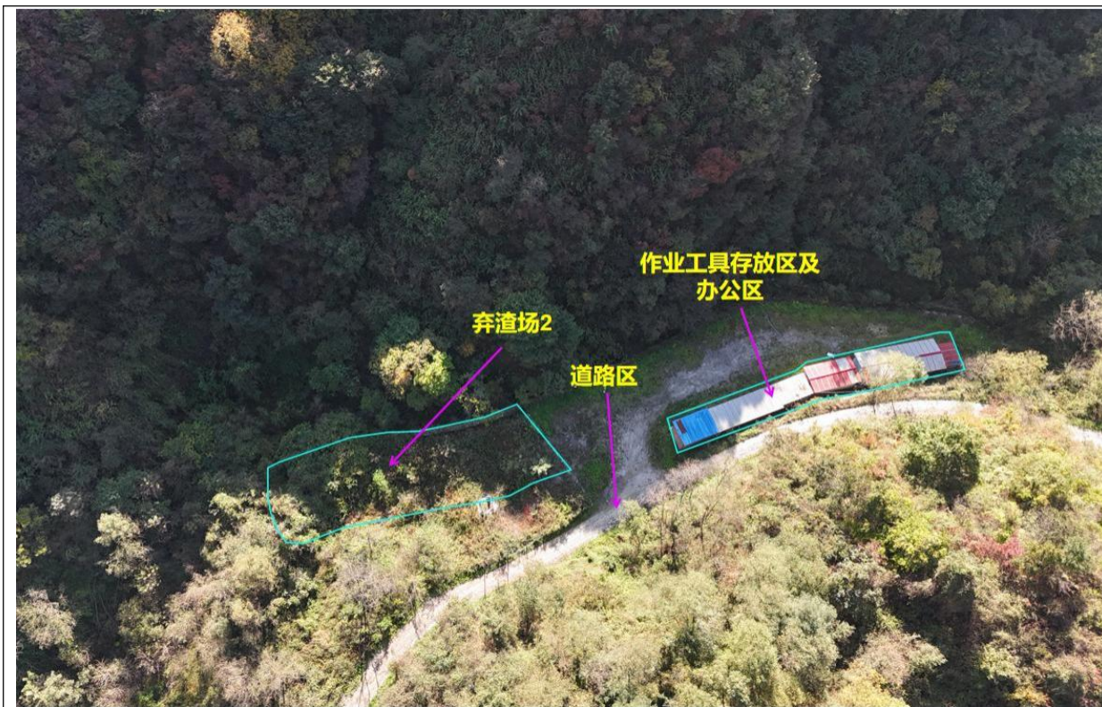
照片 2-15 工业场地建设现状 2
